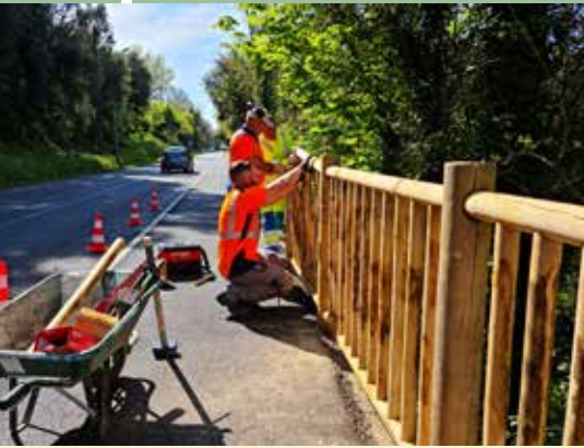
▲ Sécurisation Avenue Jean Jaurès.
